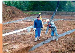
Coulage de fondations d'un sol argileux. Sources : AOC
