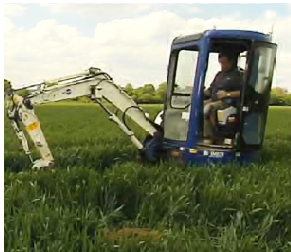
Mini-fosse à la pelle mécanique
