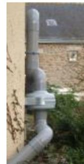
Selon la nature du soubassement il est possible de traiter ce dernier par ventilation naturelle ou mécanique pour réduire l'entrée de radon vers les volumes occupés. Il est alors important d'éviter des « zones mortes » (peu ventilées) dans le volume, en assurant un bon « balayage » de la ventilation (mettre les ouvertures en opposition de façade autant que possible).
