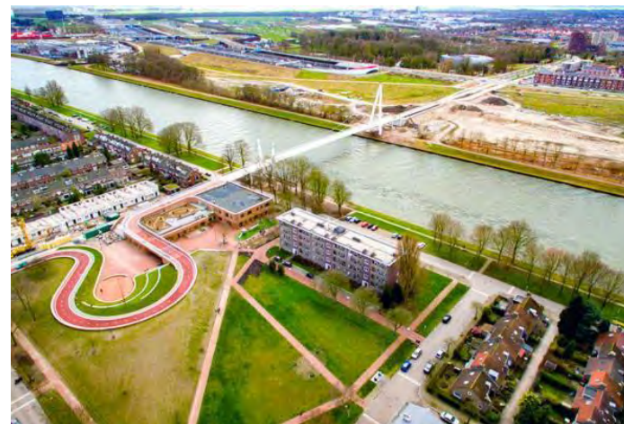
Pente tunnel douce en courbe
