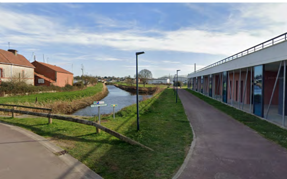
Vélomaritime est - le long du canal de la Taute
