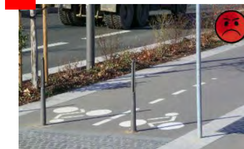
Disposition potelets dangereuses Crédits photo : cerema.fr
