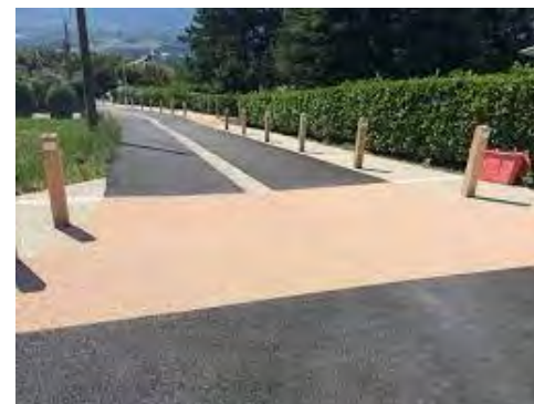
Exemples de pose de résine pour marquer une continuité ou changement de direction.
