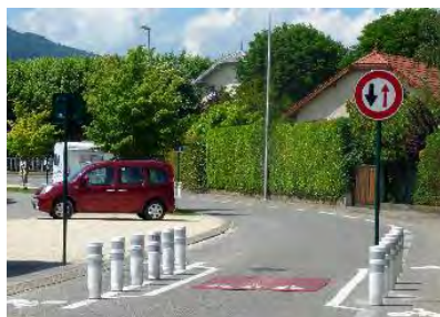
Ecluse avec passage cycliste
