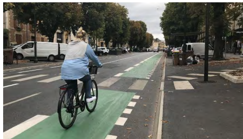
Bande avec peinture et espace tampon Charleville-Mézières
